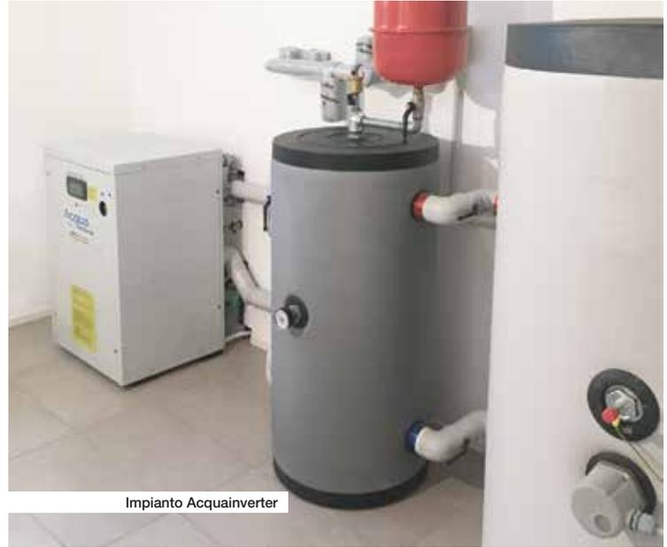
Il sistema integrato **AcquaInverter** è la soluzione ottimale per produrre energia termica alimentata da fonte rinnovabile e gestirla all'interno dell'edificio attraverso pannelli radianti a pavimento, a parete, a soffitto, ventilconvettori, radiatori termoarredi e in particolare attraverso il nuovo terminale di ECA Technology, **V-Radiant**.
